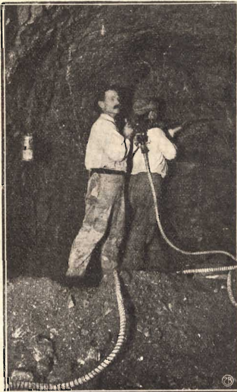
Apertura di un foro da mina col martello pneumatico.
